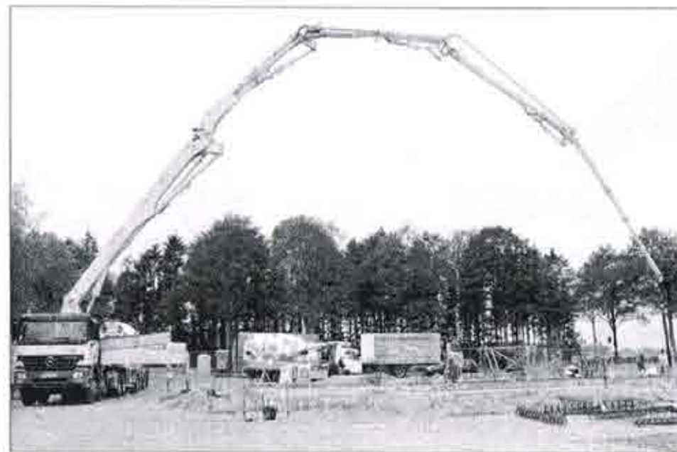
Betonlift im Einsatz: Dank der modernen Bautechnik kann der Beton schnell und sicher zur Sohlplatte gepumpt werden. Arbeiter verteilen das Material. Foto: eha
